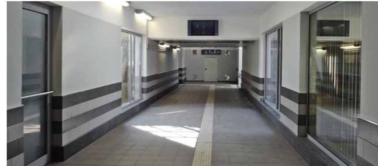
Die modernisierte Unterführung am Bahnhof Preußen steigert die Qualität der Verkehrsstation deutlich.
