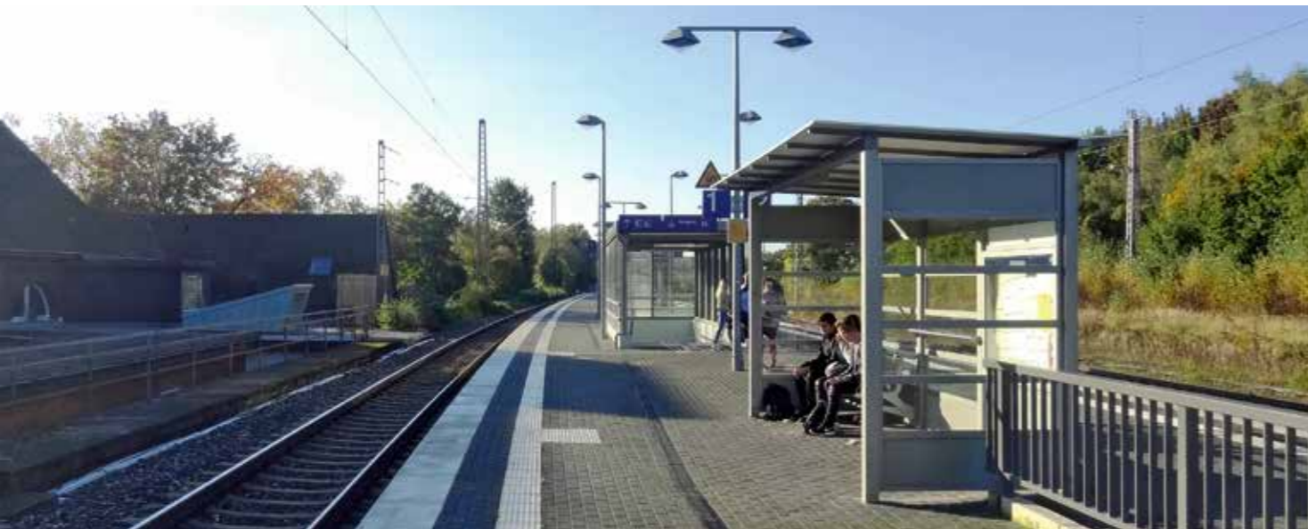
Der erneuerte und erhöhte Mittelbahnsteig am Bahnhof Preußen ermöglicht einen barrierefreien Einstieg in die Züge.
