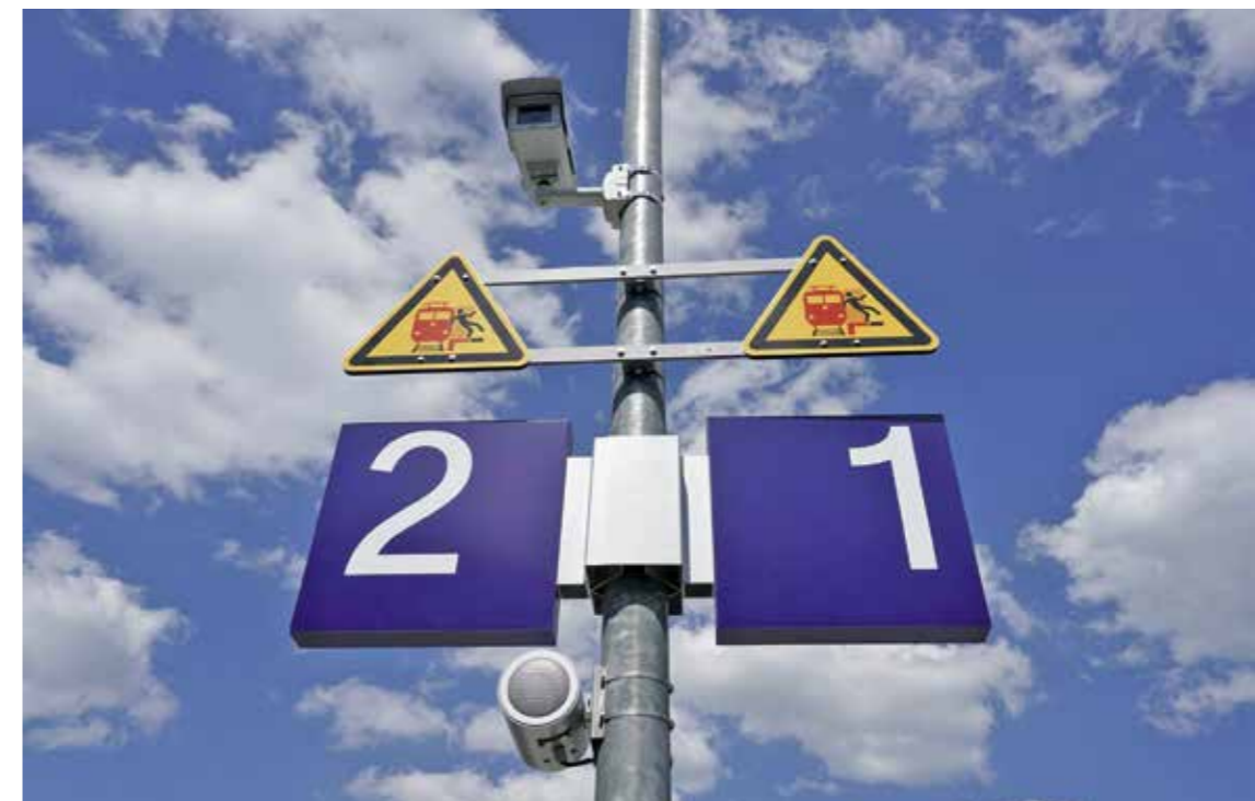
Eine Maßnahme, um die Sicherheit im SPNV zu erhöhen, ist der Einsatz von Überwachungskameras.
